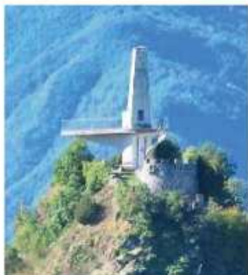
Il faro posizionato sulla pietra che domina la vallata
